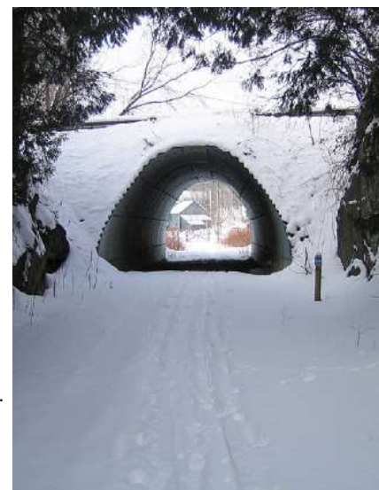
Ancien tunnel ferroviaire à Tomifobia.
